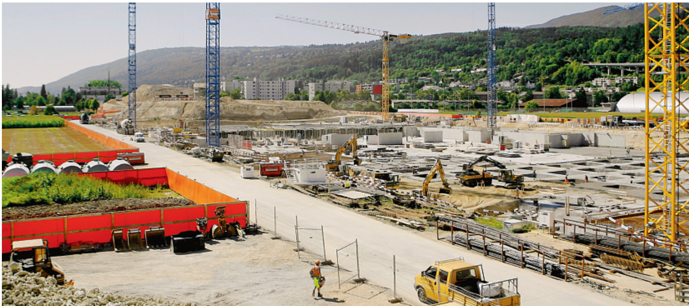
Hier wird bald in die Höhe gebaut: Die Arbeiten auf der Grossbaustelle für die Stades de Bienne kommen gut voran. Der Termin für die Eröffnung der Mantelnutzung kann dennoch nicht eingehalten werden.
